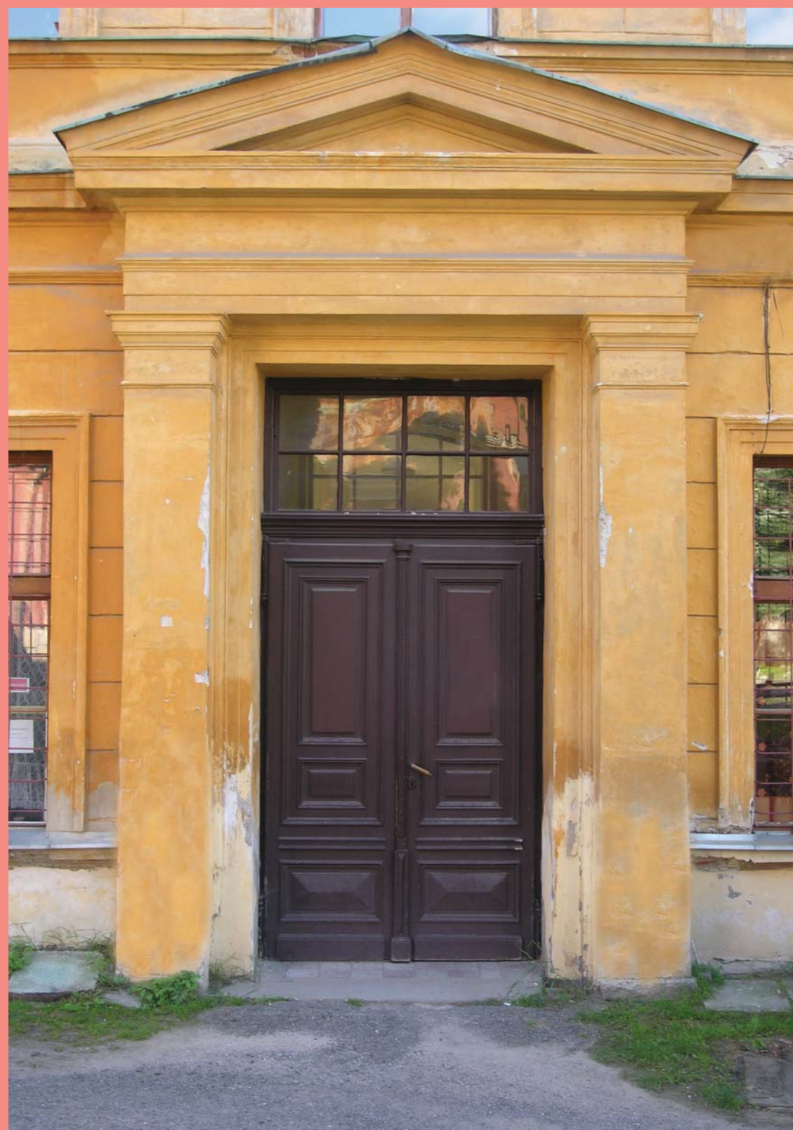
Stará základná škola v Kremnici - bočné dvojkrídlové dvere so svetlíkom orámované pilastrami a frontónom, dvere sú zasadené do neorenesančnej fasády z roku 1885
