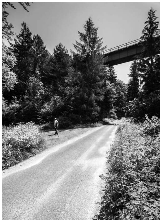
Cyklotrasa na spojenej Zlatej a Stredovekej ceste - - pred železničným viaduktom trate Horná Štubňa - Handlová
